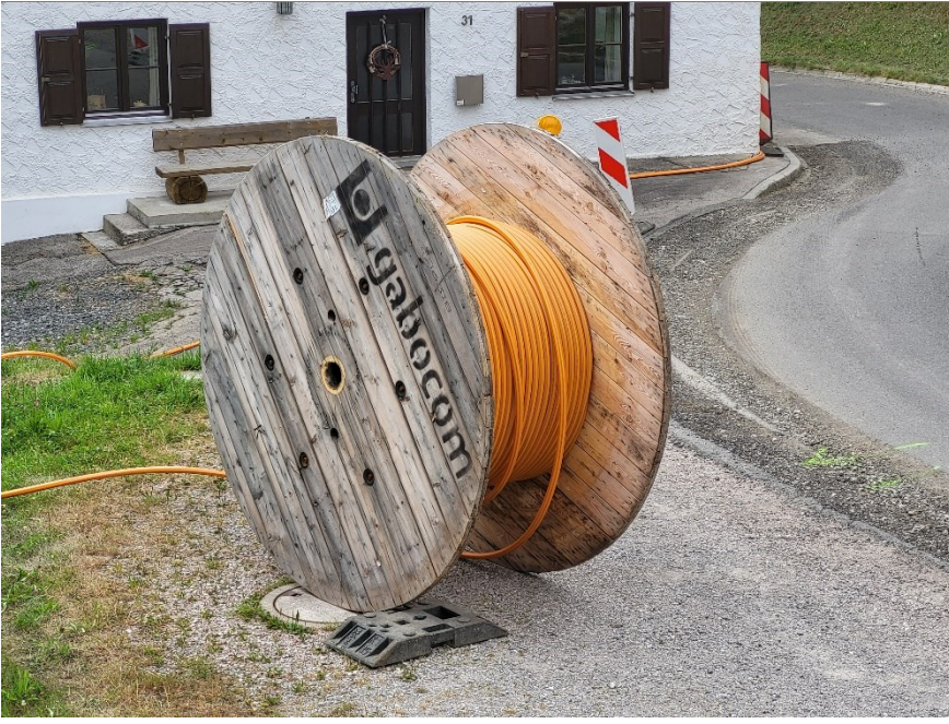
Der 3. Bauabschnitt – Hauptleitung im Dorf, Gießenschwand und Habsbichl
